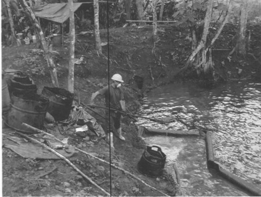
Figura 3: Operación de lavado de suelo en una piscina contaminada realizada por el PEDPA
