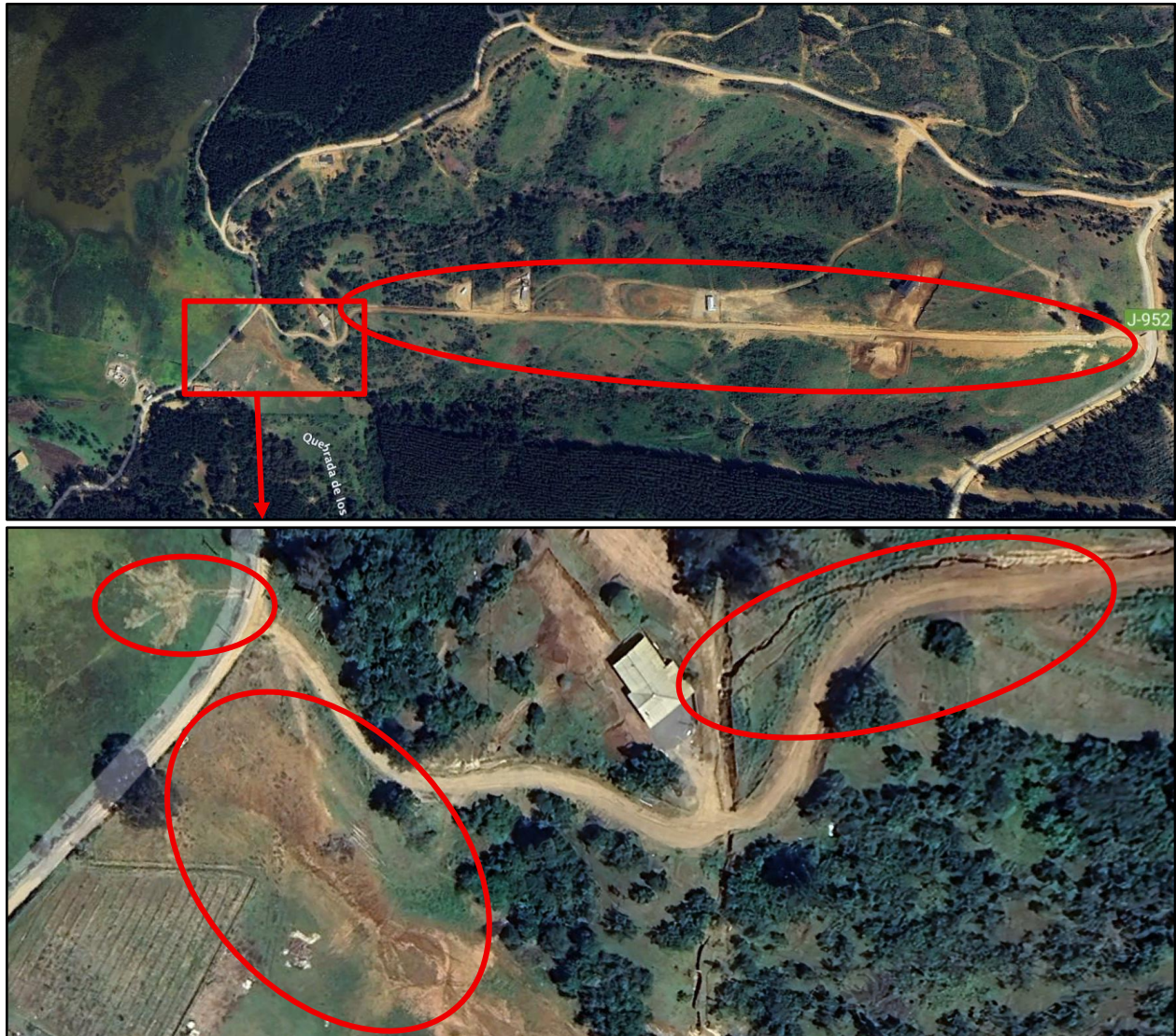
Figura 12. Desmonte del terreno en 2022/2023 a lo largo de un camino empinado construido directamente en la ladera. Observar los canales de erosión visibles y los sedimentos en la base de la colina, cerca del lago. Fuente: GoogleEarth .
