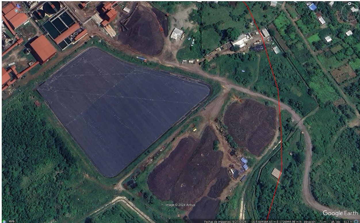
Figura 4. Se observa la acumulación de pilas de material triturado, que podría ser óxido de hierro, sin ningún tipo de medida para evitar su dispersión con el viento ni el agua, conformando una fuente de contaminación para el entorno y amenazando la salud de las comunidades aledañas y aguas abajo.
