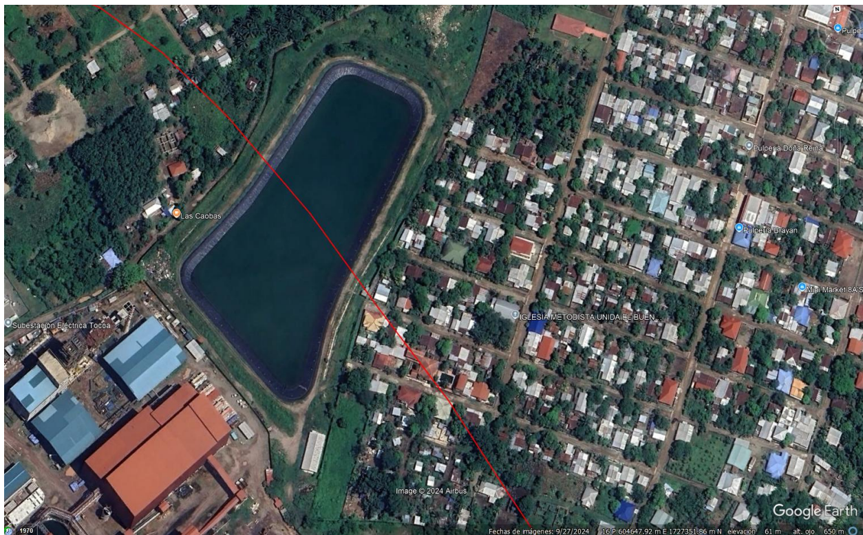
Figura 5. Tranque de acumulación de agua. El complejo industrial Ecotek se abastece de un pozo de aguas subterráneas. En los EIA no se caracterizaron los acuíferos ni la disponibilidad hídrica con la que cuentan, ni los usuarios que dependen de ella.
